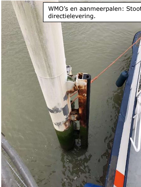
Ladders en valstopper rail te vernieuwen. 1 rail is directielevring, rest scope ON.
