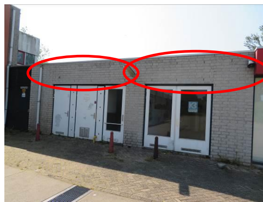
Foto 2: aanzicht van een deel van de bakstenen muur, er zijn stootvoegen aanwezig die gebruikt kunnen worden door gebouwbewonende vleermuizen als invliegopening. Korte delen van dit gebouw zijn ook voorzien van bakstenen met stootvoegen.
