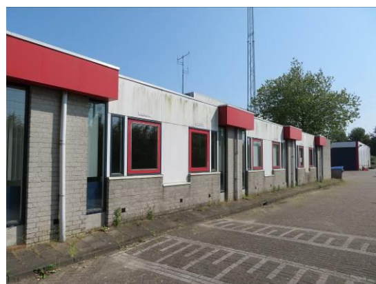
Foto 6: aanzicht van de westzijde van het lage gebouw aan de noordkant van het plangebied.
