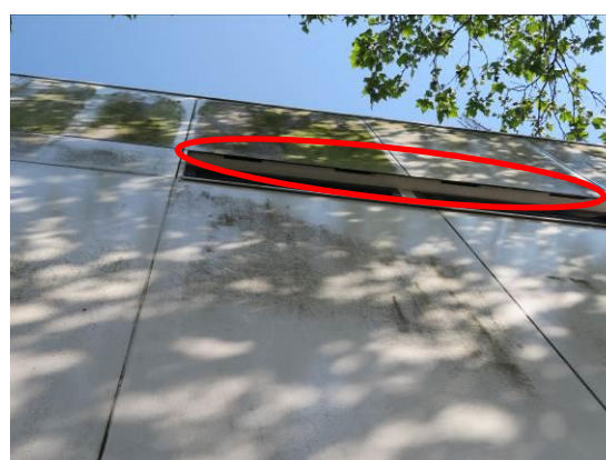
Foto 8: op de westkant van de kazerne bevinden zich op de eerste verdieping, boven de ramen, gaten achter de wandpanelen.
