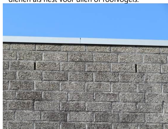
Foto 20: deze muur heeft stootvoegen bij de dakrand die geschikt zijn als invliegopening voor gebouwbewonende vleermuizen.
