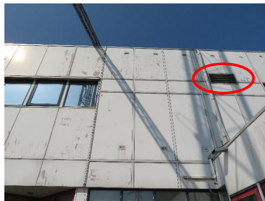
Foto 10: aanzicht van de zuidzijde van de noordelijke kazerne, het rooster kan mogelijk gebruikt worden als invliegopening van gebouwbewonende vleermuizen en gierzwaluwen (als deze uit staat).
