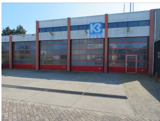
Foto 3: aanzicht van de voormalige brandweerkazerne.
