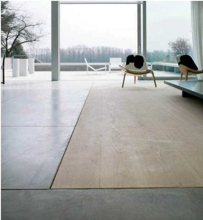
betonvloer met houten vloervlak
