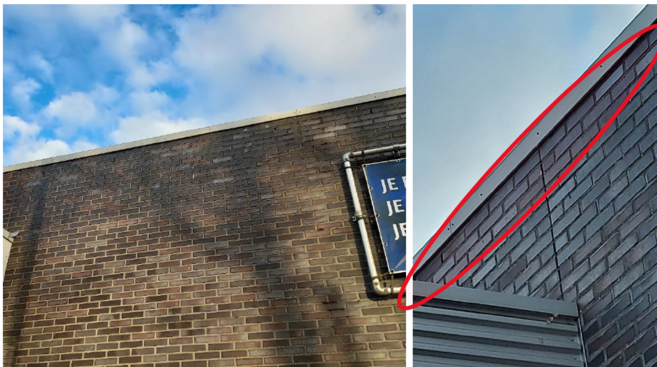
Figuur 21: Open stootvoegen en dakranden met genoeg ruimte voor vleermuizen.
