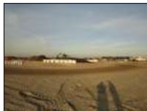
Figuur 7. Voorbelaste grond waarop startende bouwwerkzaamheden plaats zullen vinden.
