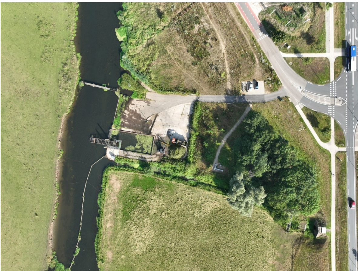
Bovenaanzicht huidige vuilvanginstallatie in 2022
