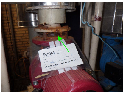
Aanzicht pakking, monster 3 en pakking, tussen flensen cv ruimte
