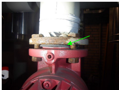
Aanzicht pakking, monster 3 en pakking, tussen flensen cv ruimte
