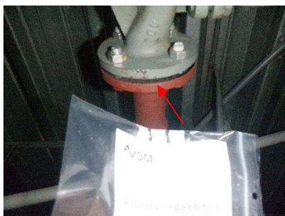
Aanzicht pakking, monster 10 en pakking, tussen flens afsluiter boven plafond 2e verdieping
