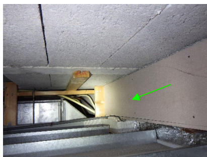
Aanzicht board, monster 11 en board, bekleding H-balken 1e verdieping
