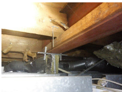
Aanzicht constructie b.g. en 2 e verdieping niet brandvertragend bekleed
