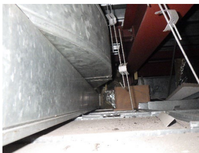
Aanzicht constructie b.g. en 2 e verdieping niet brandvertragend bekleed
