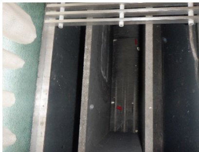
Aanzicht wandtegels gezet in specie en binnenzijde convectorput
