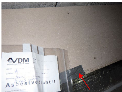
Aanzicht board, monster 11 en board, bekleding H-balken 1e verdieping
