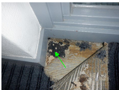
Aanzicht bitumineuze lijmlaag, monster 7, 8, 9, 12 en 13 en bitumineuze lijmlaag
