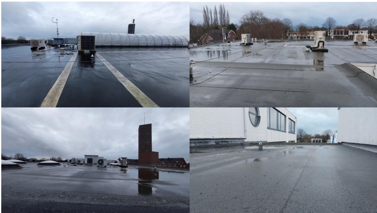
Figuur 4.4.1. De platte daken bevatten geen kiezels.
