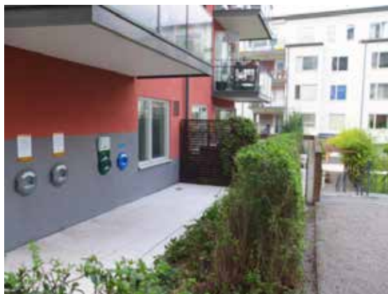
Voorbeeld van een ondergronds transport afvalstelsel (afvalinzamelpunt in Stockholm).
