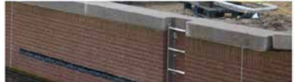
Uitklimtrap RVS verwerkt in de kadeconstructie
