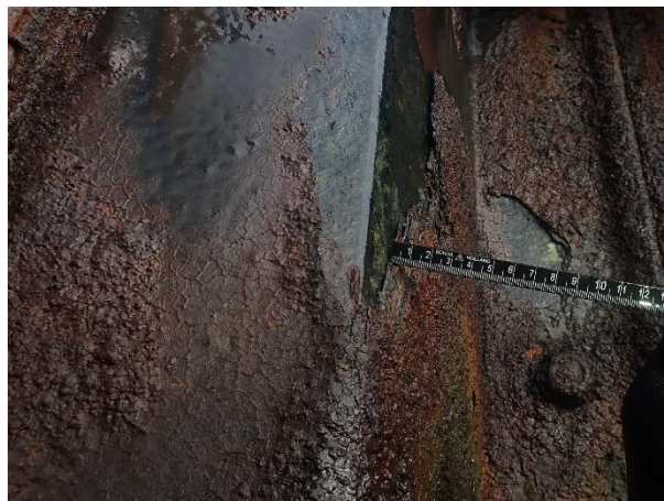
Figuur 7.4: Roestproduct boven de waterlijn.
