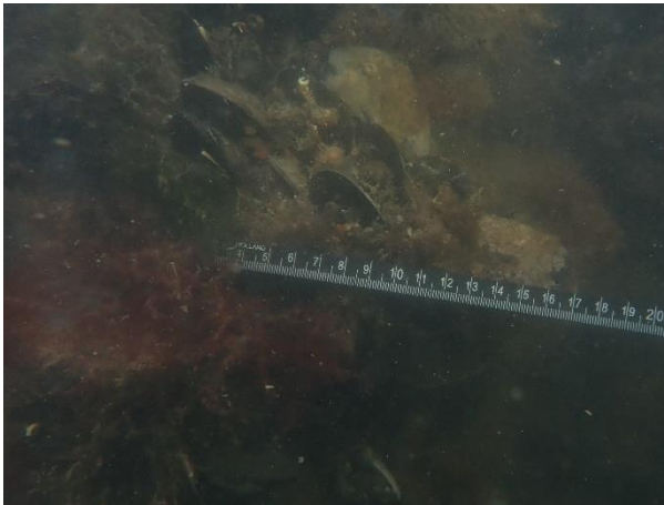
Figuur 7.7: Begroeiing op de damwand.
