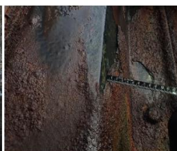
Figuur 7.4: Roestproduct boven de waterlijn.
