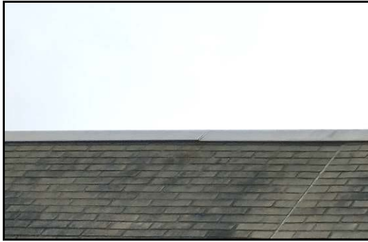
Afbeelding 5: ruimte onder de dakrand.
