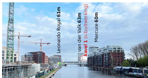
Afbeelding 11: Lucht tussen hoogbouw vanaf Duivendrechtsevaart
