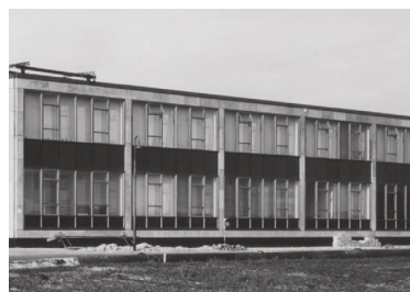
Colafabriek - kantoorvolume: Betonpanelen met houten kozijnen
