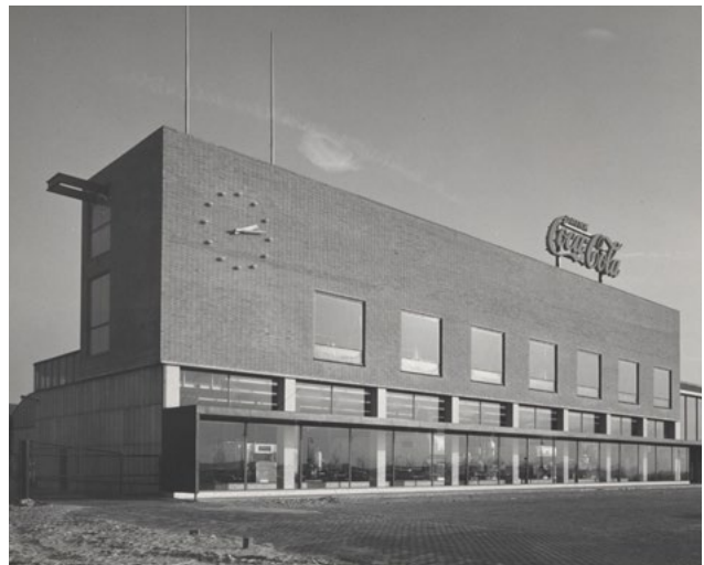
Hoofdgebouw van de Coca Cola fabriek in baksteen kort na voltooiing
