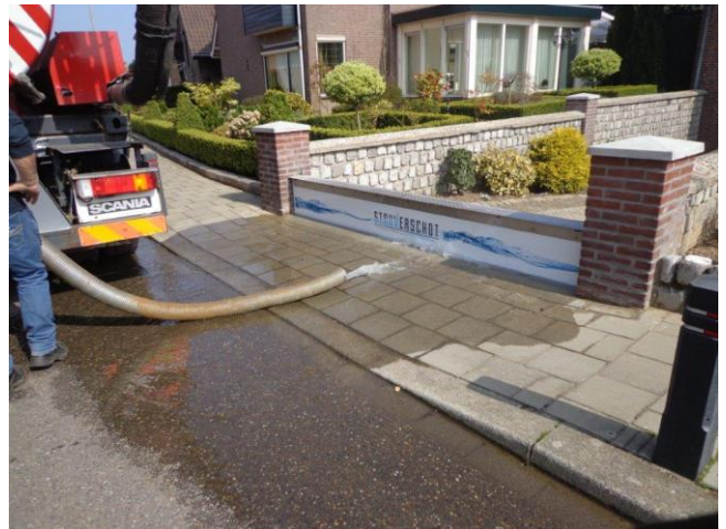
Figuur 4: Maatregel Dorpstraat 133 Asenray
