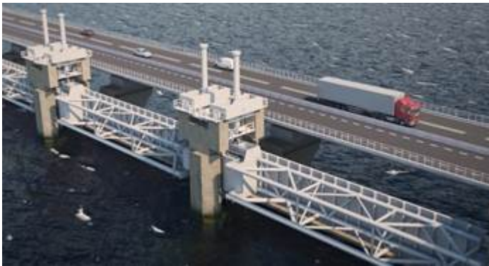
Figuur 2: Schuiven en Pijlers Oosterscheldekering
