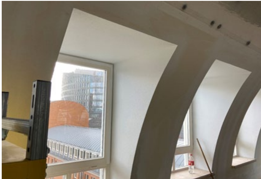
Figuur 2 Impressie van de binnenzijde uit de bouwfase. Foto is toegevoegd om duidelijk te maken dat het slopen van een dakkapel ingrijpt op de huidige detaillering.
