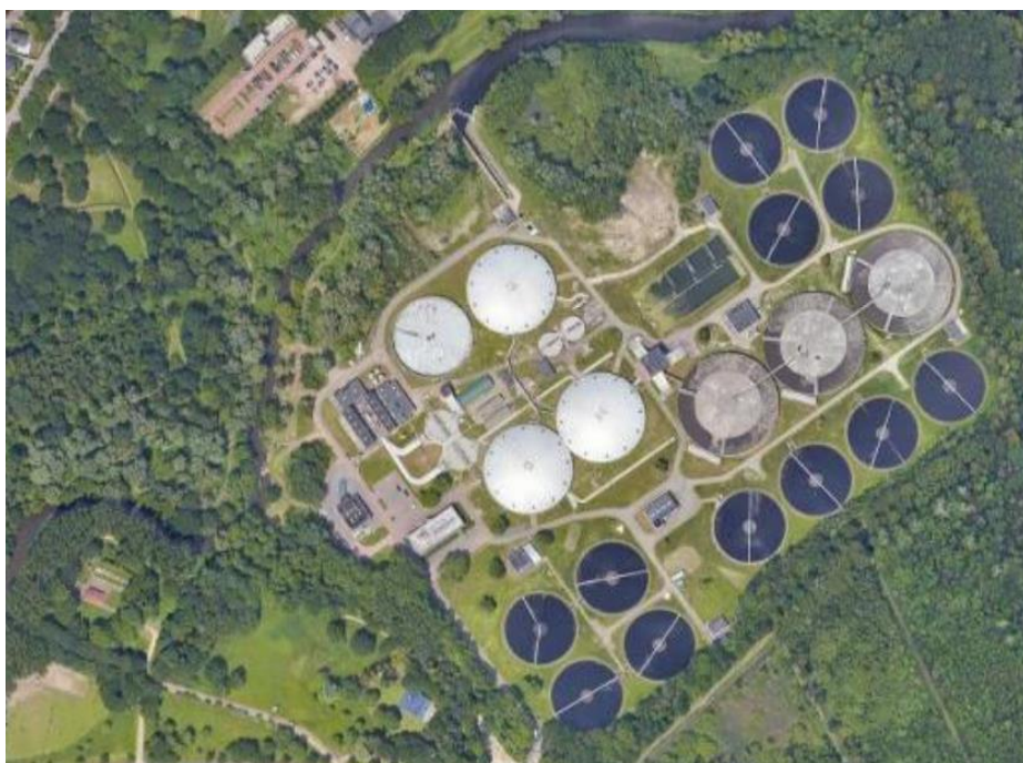
Afbeelding 1-1: Luchtfoto RWZI Eindhoven
