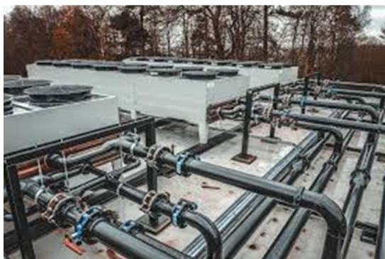
Afbeelding 5-1: Voorbeelden van droge koelers op daken of grondgebonden, toegepast voor regeneratie.
