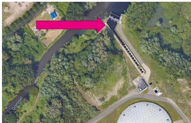
Figuur 6-2: Luchtfoto RWZI Eindhoven, inclusief locatie onttrekking
