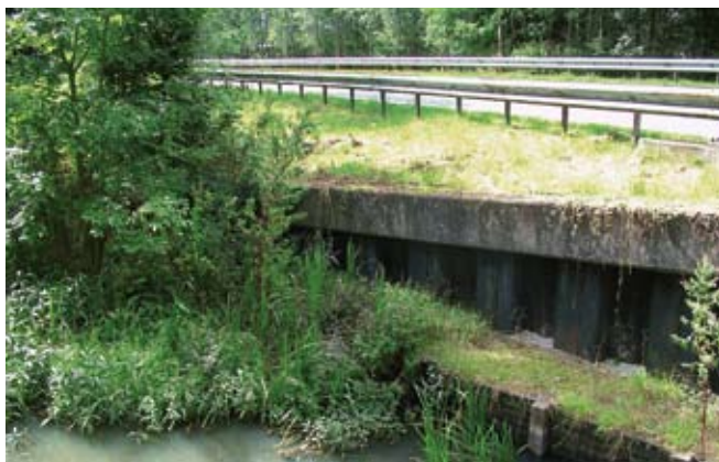
Geleidende beplanting bij loopstrook, die na een haakse bocht onder oprit A1 doorloopt.
