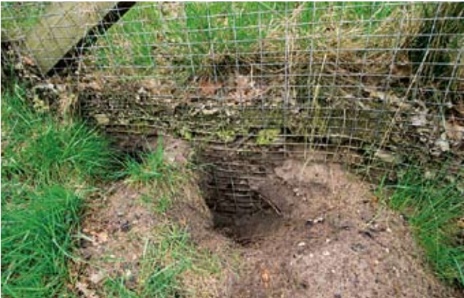
Boven: poging tot ondergraving maar raster reikt diep genoeg.
