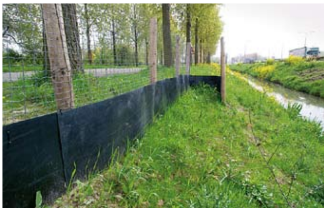
Amfibieënscherm langs parallelweg A13 bij Delft.
