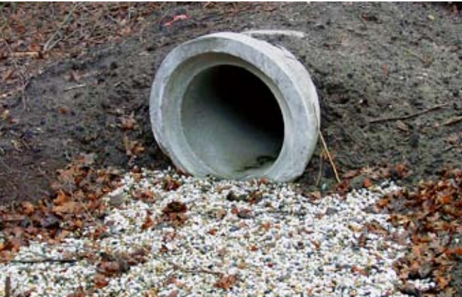
Boven: grindkoffer laat water goed door.
