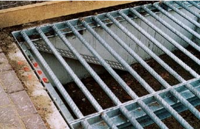
Boven: roosterput schoon en voorzien van uitklimvoorziening.
