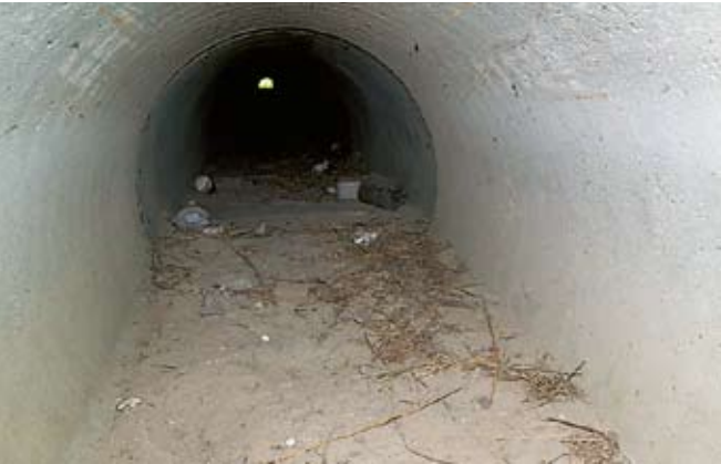
Boven: tunnel goed passeerbaar, vrij van obstakels.
