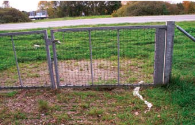
Boven: werkpoort gesloten, raster loopt door op de poort. Onder: teveel ruimte tussen dorpel en onderkant werkpoort.
