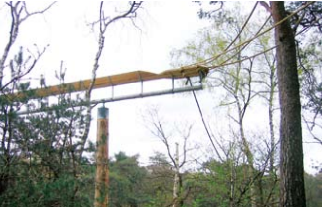
Boven: goede verbinding tussen loopgoot en bomen.
