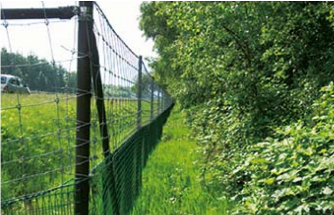
Boven: goed toegankelijk voor inspectie.
