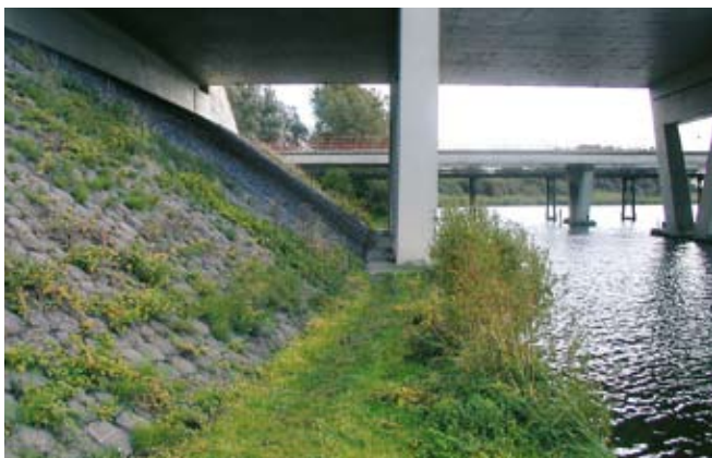
Brug met doorlopende oever langs het Zuiderdiep.
