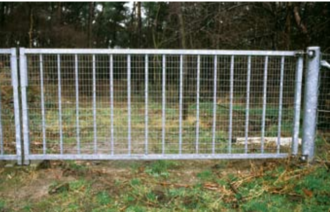
Boven: werkpoort gesloten, raster loopt door op de poort. Onder: teveel ruimte tussen dorpel en onderkant werkpoort.
