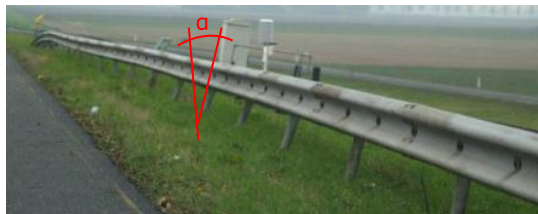
Afbeelding 7 Scheefstand van een geleiderail
