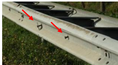
Afbeelding 12 Bevestigingsmiddelen niet correct aangehaald
