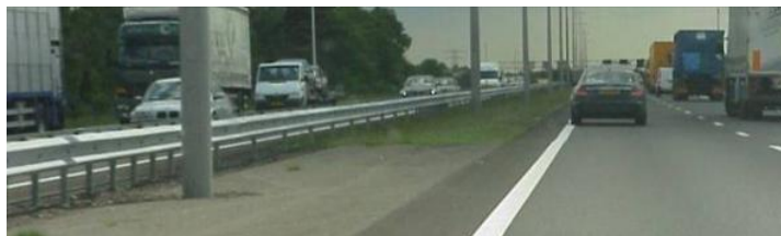
Afbeelding 16 Lichtmasten geplaatst in de middenberm zonder afscherming
