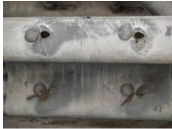
Afbeelding 24 Ernstige hak en slijpsporen
