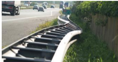
Afbeelding 17 Beschadigde geleiderailconstructie
