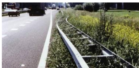
Afbeelding 21 Scheefstand klasse V
