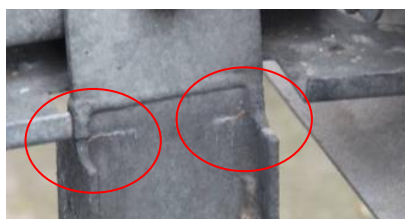
Afbeelding 28 Inscheuring van de stijl
