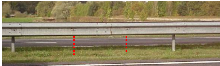
Afbeelding 18 De schuifconstructie, extra palen ontbreken voor ondersteuning
