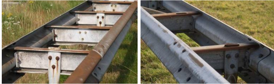
Afbeelding 32 Roestvorming geleiderail
