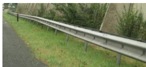
Afbeelding 22 Scheefstand klasse III/IV
