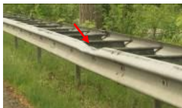
Afbeelding 8 Beschadigde plank
