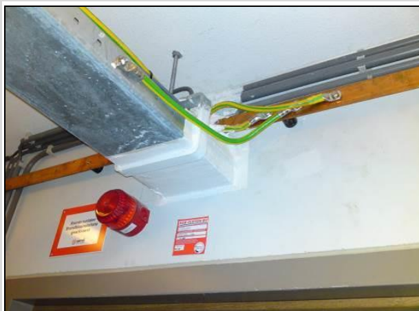
Figuur 12.5 Koppeling binnenkomende goot met ringleiding
