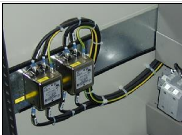
Figuur 15.3 Klemaansluiting motorkabel frequentieregelaar
