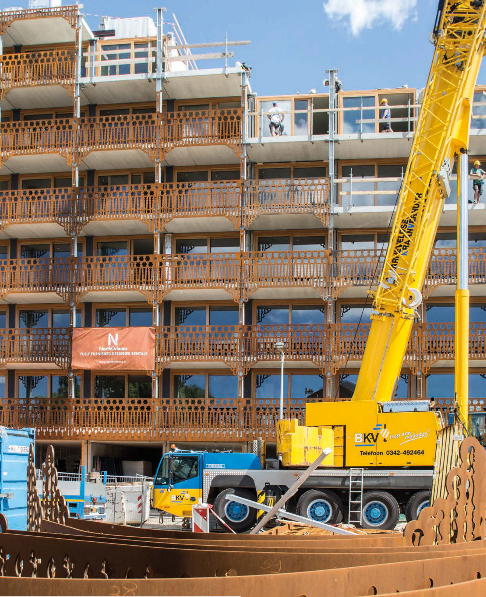
Appartementencomplex in aanbouw in het Hamerkwartier, Amsterdam Zuid.
