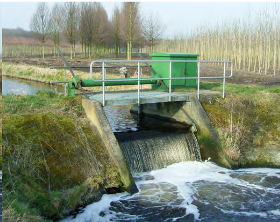
Huidige situatie stuw ZL1-st4
