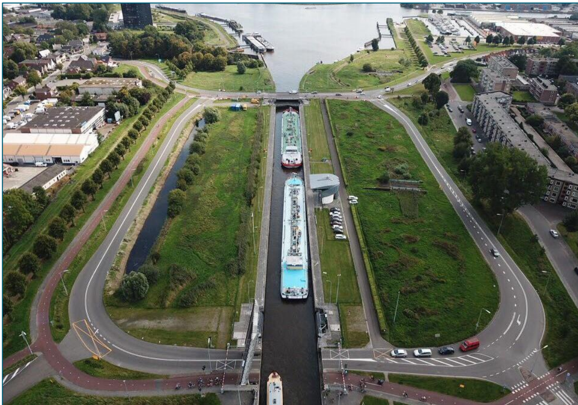
Abbeelding 5.2 Referentie: twee verkeersbruggen bij Oostersluis, Groningen
