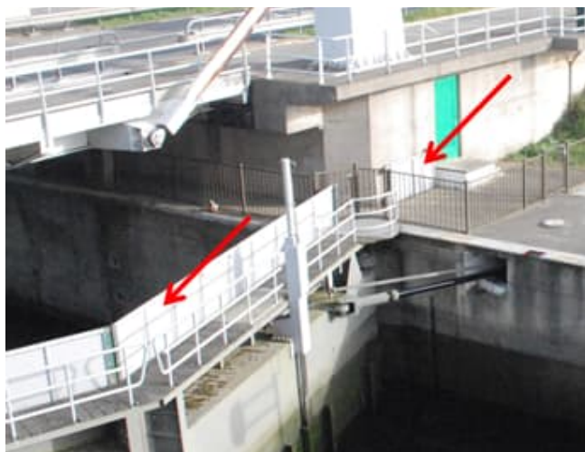
Figuur 1-2: Weergave - met rode pijlen- vloeddeurtjes en dichte reling t.b.v. functie waterkeren [Foto 3-4-2014]
