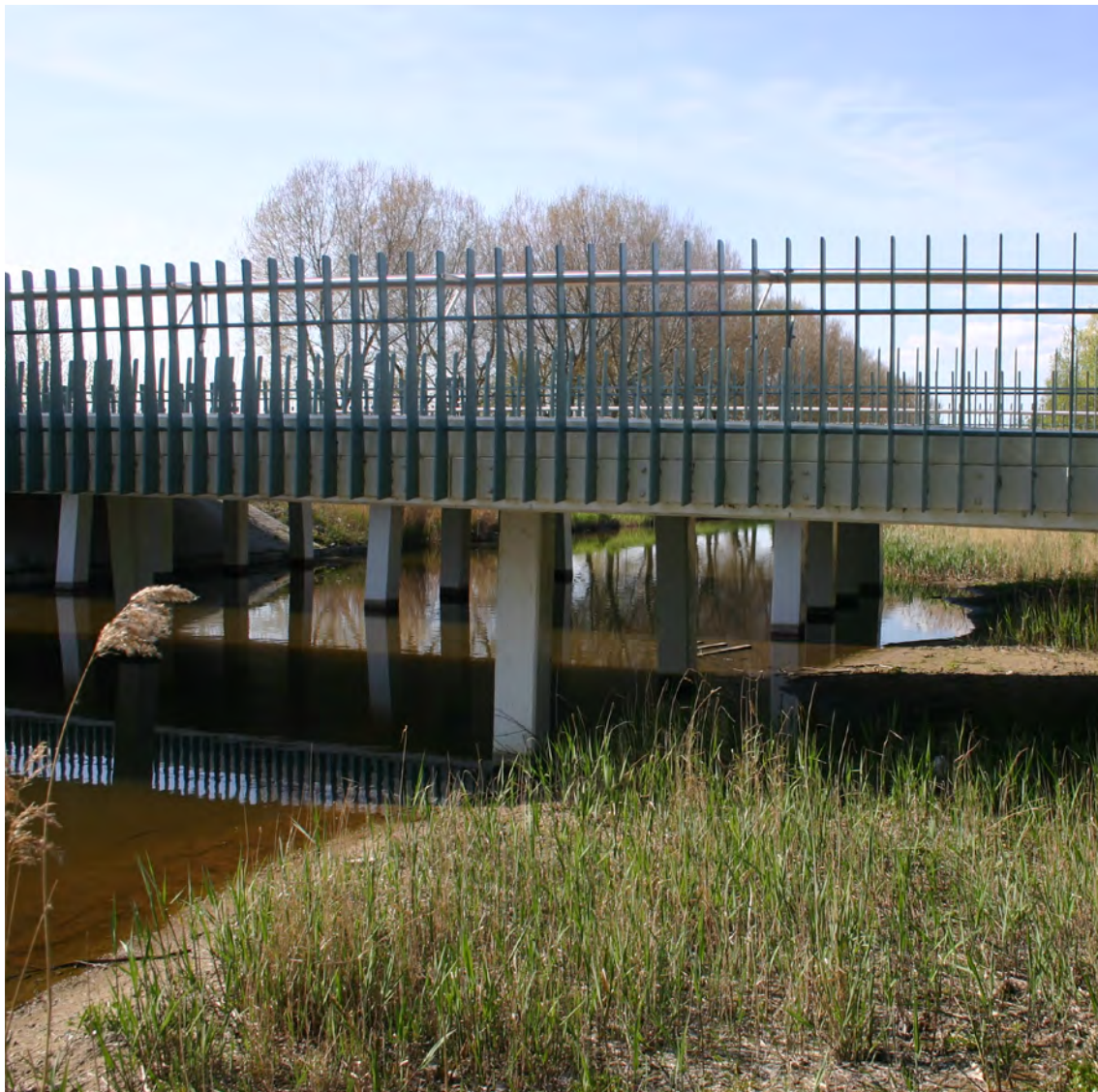
Figuur 9: brug met rechts een droge faunapassage
