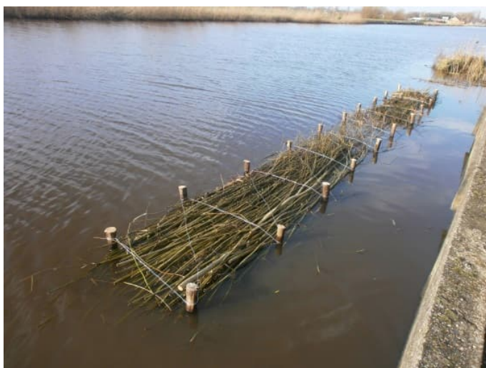
Figuur 2.12 Voorbeeld van takkenstructuren vastgelegd met palen en ijzerdraad
