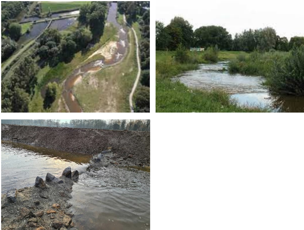
Figuur 2.1. Voorbeelden van een natuurtechnische vispassage opgebouwd met v-vormige overlaten en een vertical slot. Boven; Bovenmark, vispassage langs stuw Bieberg, onder; overlaat van de vispassage in de Snelle Loop.
