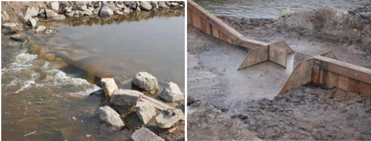
Figuur 2.9 Metalen damwandenbak met vertical slot ingebouwd in de damwand van een drempel in aanbouw.
