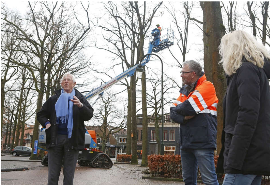
Foto: werkzaamheden bomen Brink
