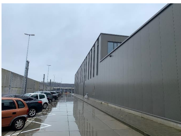
Situatie zuidelijke gebouwgevel.
