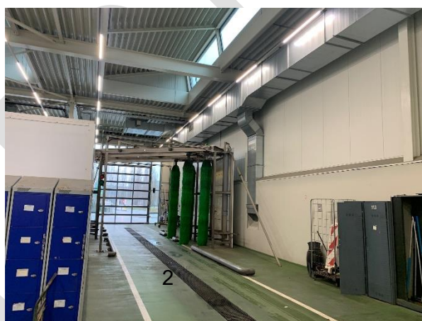
Gebouw 3: inblik in de reinigingsruimte.
