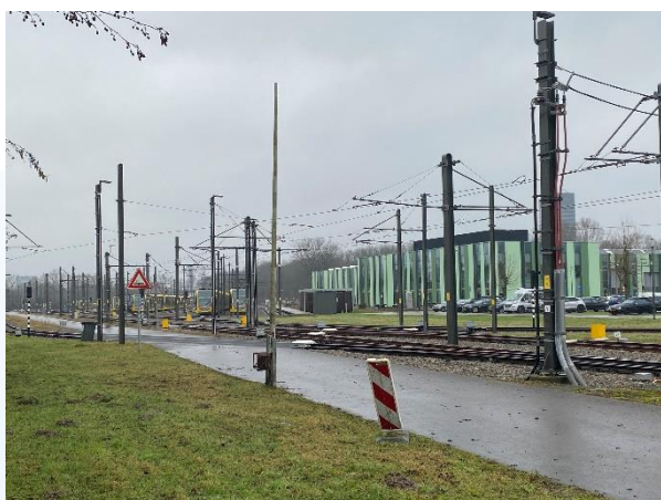
Links de remise, rechts het gebouw
