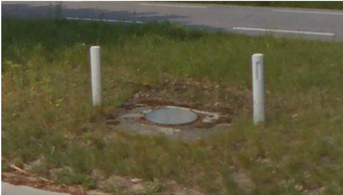
Fauna inspectieput gecombineerd met lichtkoker
