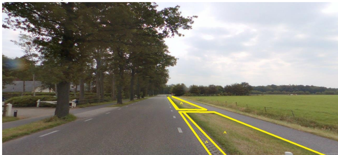
Berm bestaat uit grasklinkers en gras; hier in 2 aparte vlakken
