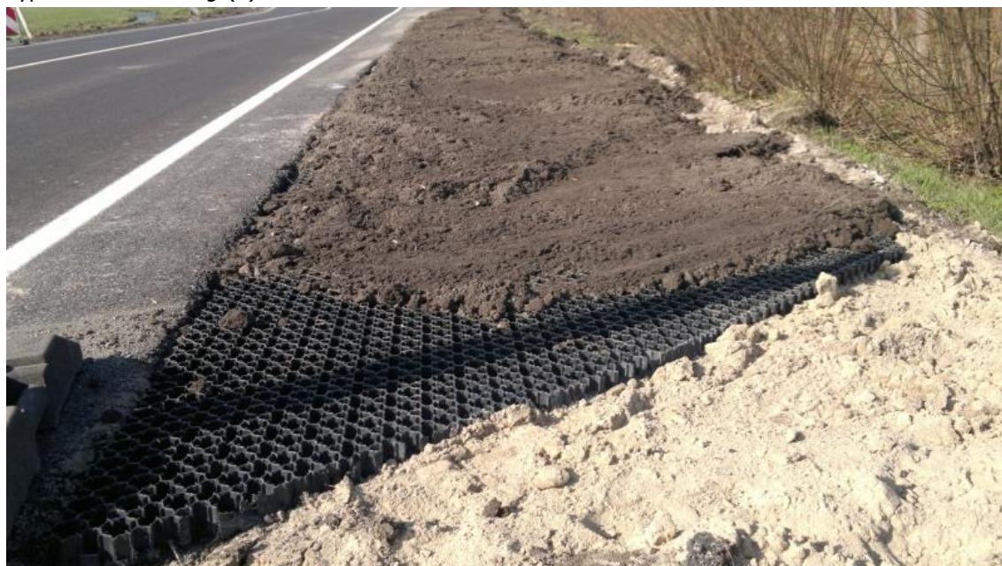
Type bermverharding bij aanleg.
