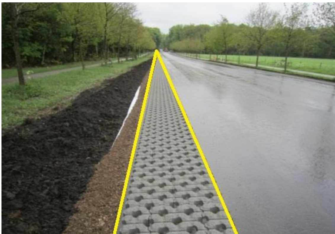
Type Bermverharding (bij aanleg): Zelfreinigende wegberm
