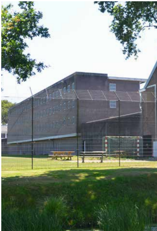
noordgebouw Norgerhaven - te amoveren deel
