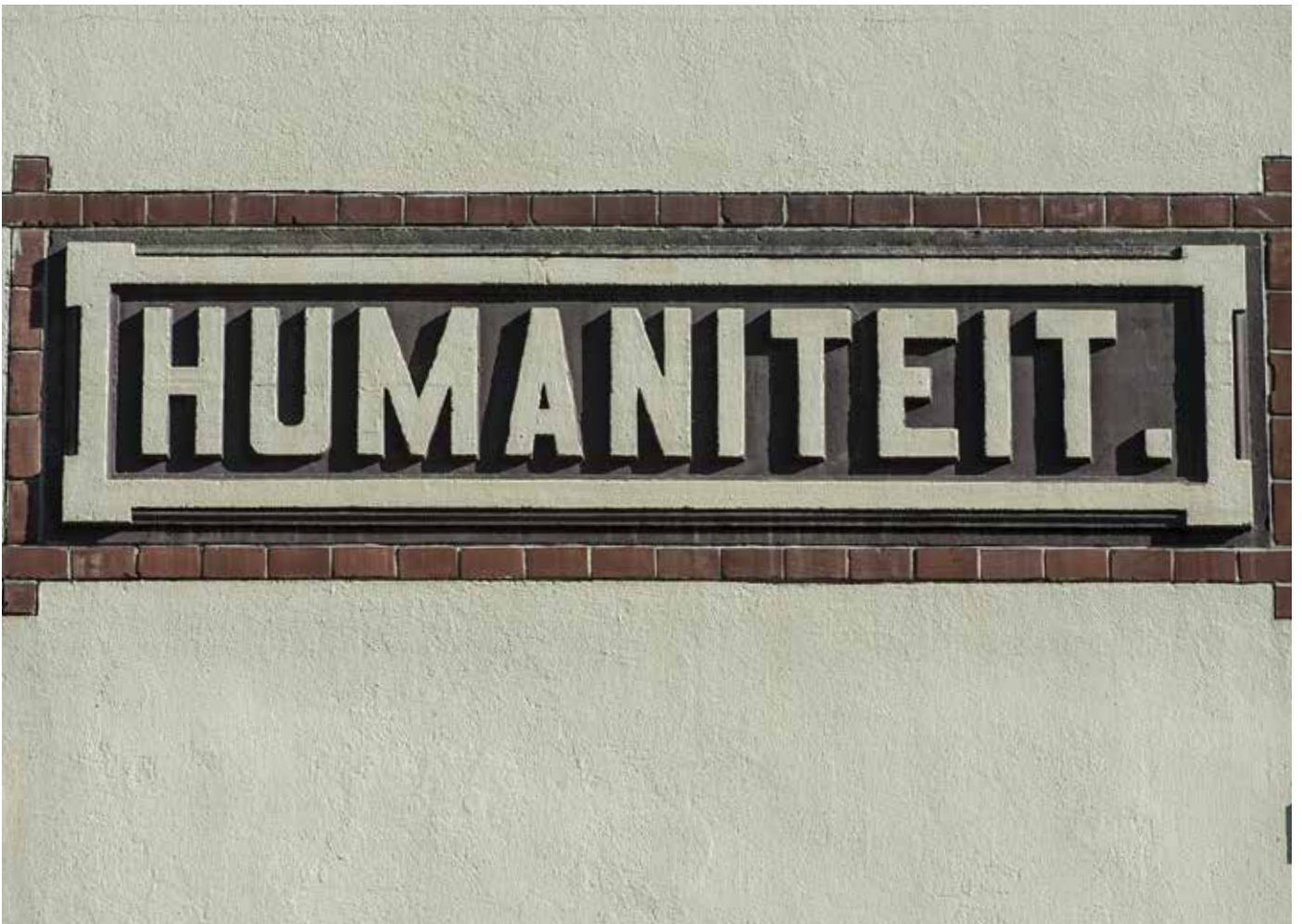
voorbeeld gevelteksten Veenhuizen
