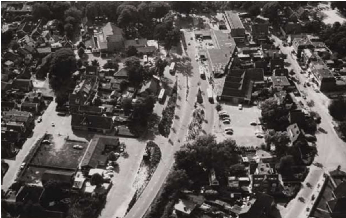
Figuur 2.3 Luchtfoto genomen voor de sloop van de kolenloodsen. In één oogopslag is duidelijk hoe groot het gat is tussen de beide groene, kleinschalige dorps helften.
