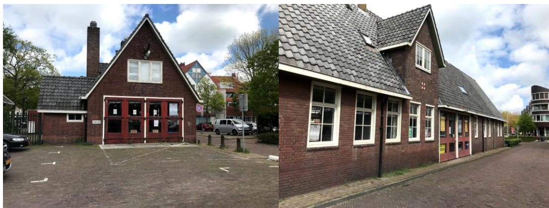
Figuur 3.1. Bijgebouw brandweer dat dient te worden gesloopt. Op de voorgrond te saneren parkeerplaatsen op maaiveld
