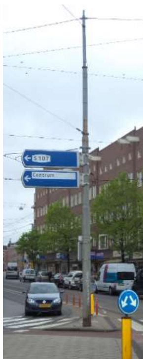
Bovenleidingmast met bewegwijzering
