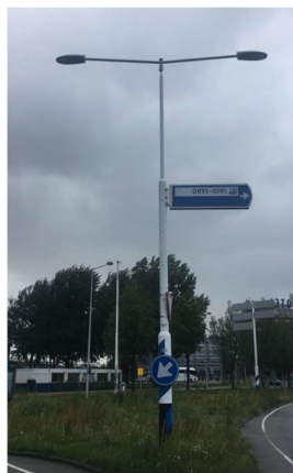
Uithouder + armatuur op bewegwijzeringsmast
