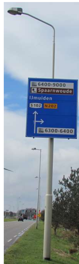
Bewegwijzeringsbord op lichtmast (maximaal gewicht 15 kg.)
