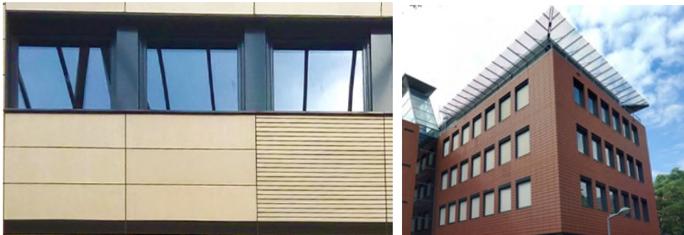
Figuur 6 Links: Houten panelen van de binnengevel. Rechts: Keramieken buitengevel met rationeel systeem. Op de bovenetage is een zonneluifel zichtbaar.
