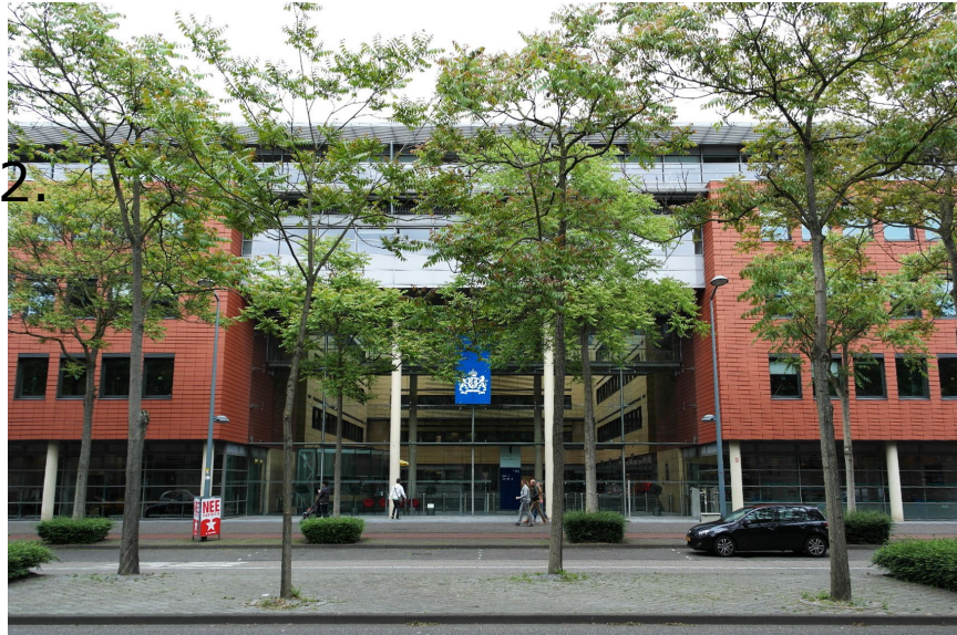
Gebouw Rijkskantoor aan de Avenue Ceramique 125
