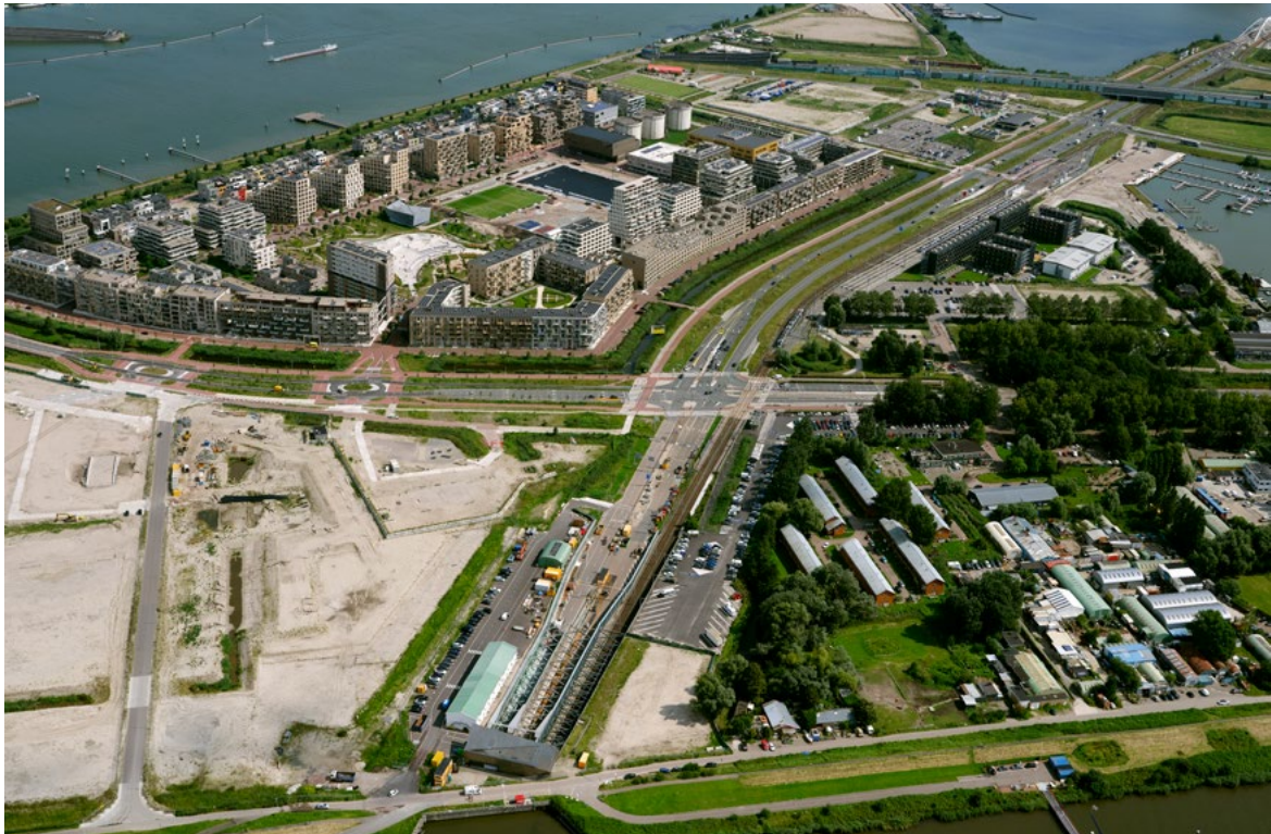
Figuur 20. Luchtfoto Zeeburgereiland (Your Captain luchtfotografie).
