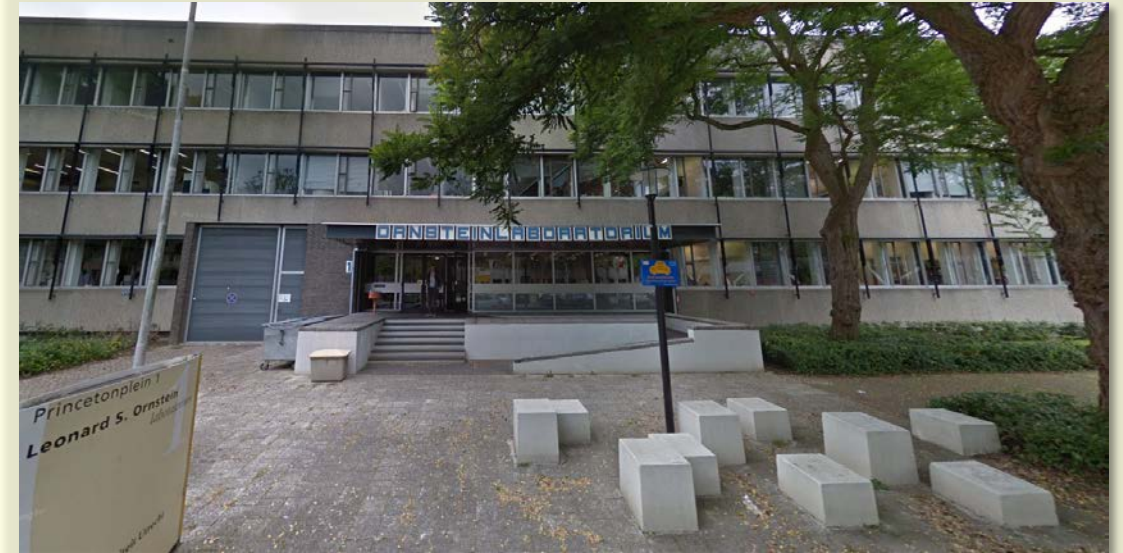
Foto: De entree van het Ornsteinlaboratorium. Het huidige idee is om dit de hoofdentree te maken voor het complex SL2/Ornstein
