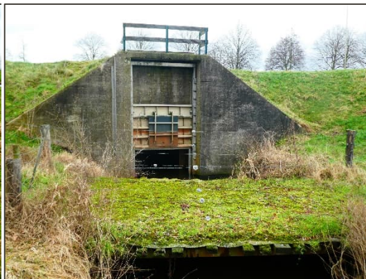
Afbeelding 8. Duiker van de Kroonbeek onder de dijk en N271.
