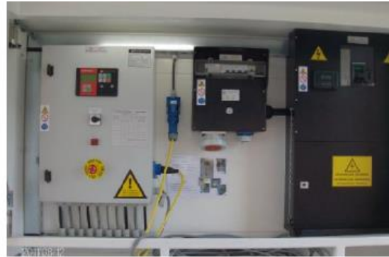
Fig. 18.3 : Noodstroom aggregaat NSA800-71 kan continue 690kVA vermogen leveren bij uitval elektrische energie.
