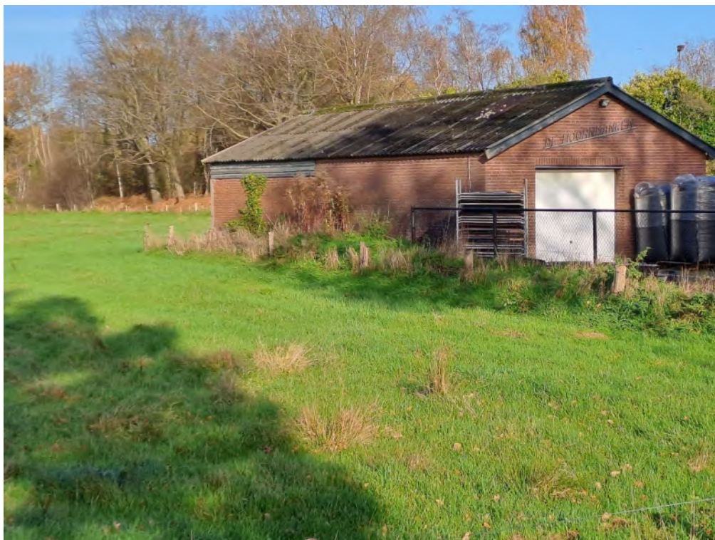
Foto 3: schuur met asbestverdachte beplating (Biezenmortelsestraat 39)
