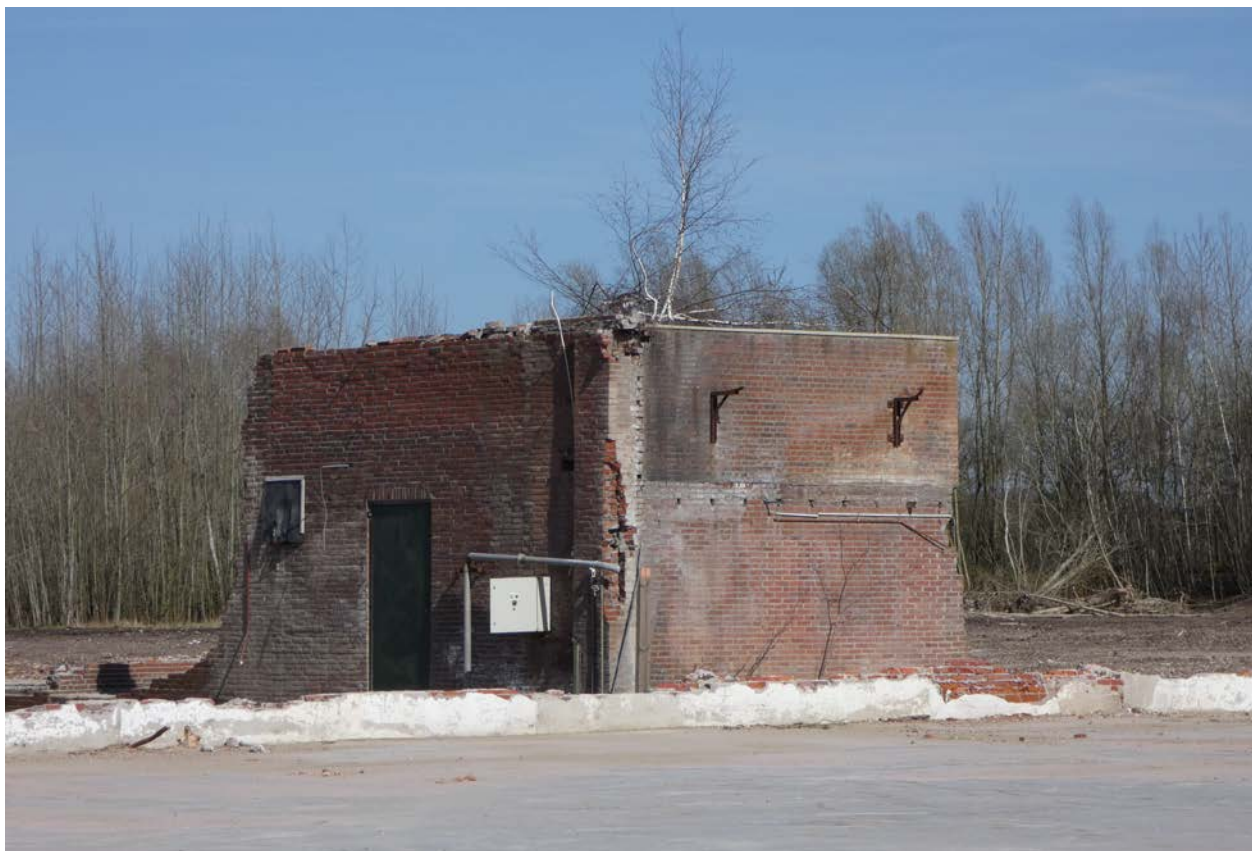
Figuur 2-20: Voormalig trafohuisje van de steenfabriek.
