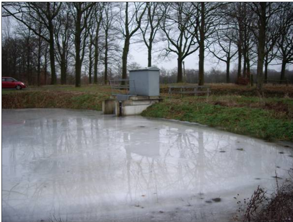
Foto B5.12: Gemaal Assisie (links bemalingszijde, rechts Koolenvense Waterloop)
