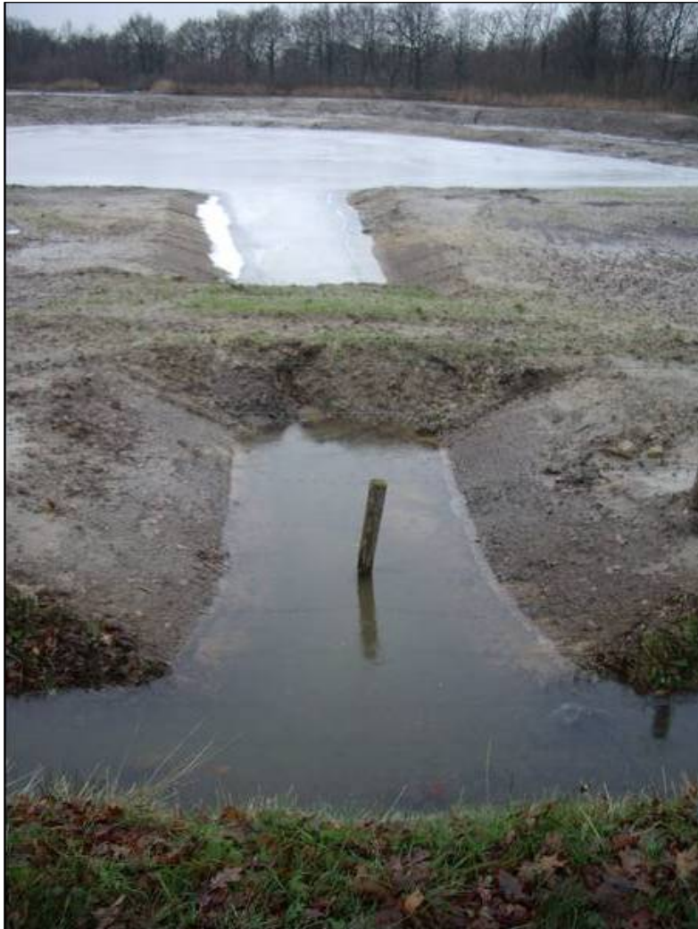
Foto B5.6: Het heringerichte gebied Kreitenheide is afgedamd van de sloot welke naar het gemaal gaat
