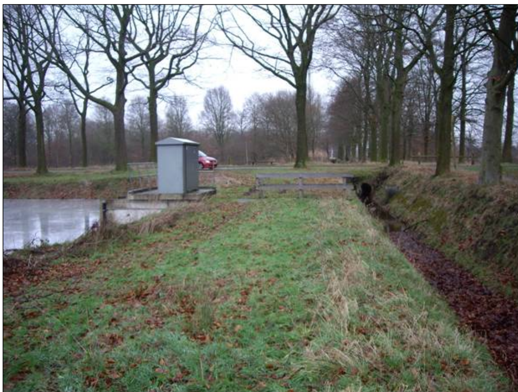
Foto B5.13: Gemaal Assisie (links bemalingszijde, rechts Koolenvense Waterloop)
