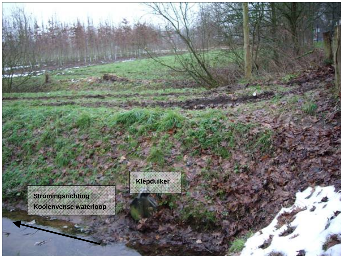
Foto B5.10: Klepduiker waarop de percelen met boomkwekerij afwateren op de Koolenvense waterloop
