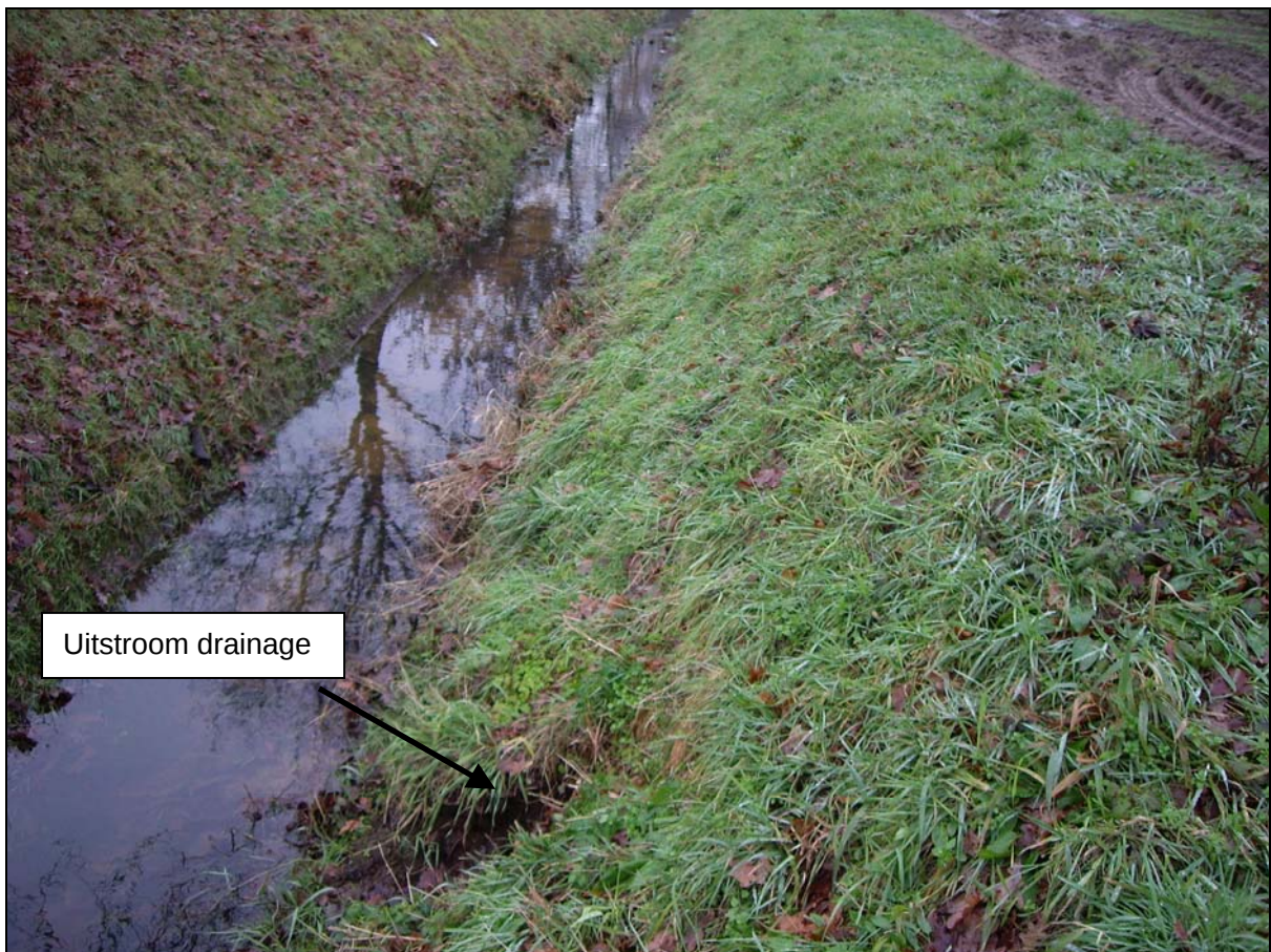
Foto B5.1: Drainage welke uitkomt in de Koolenvensewaterloop
