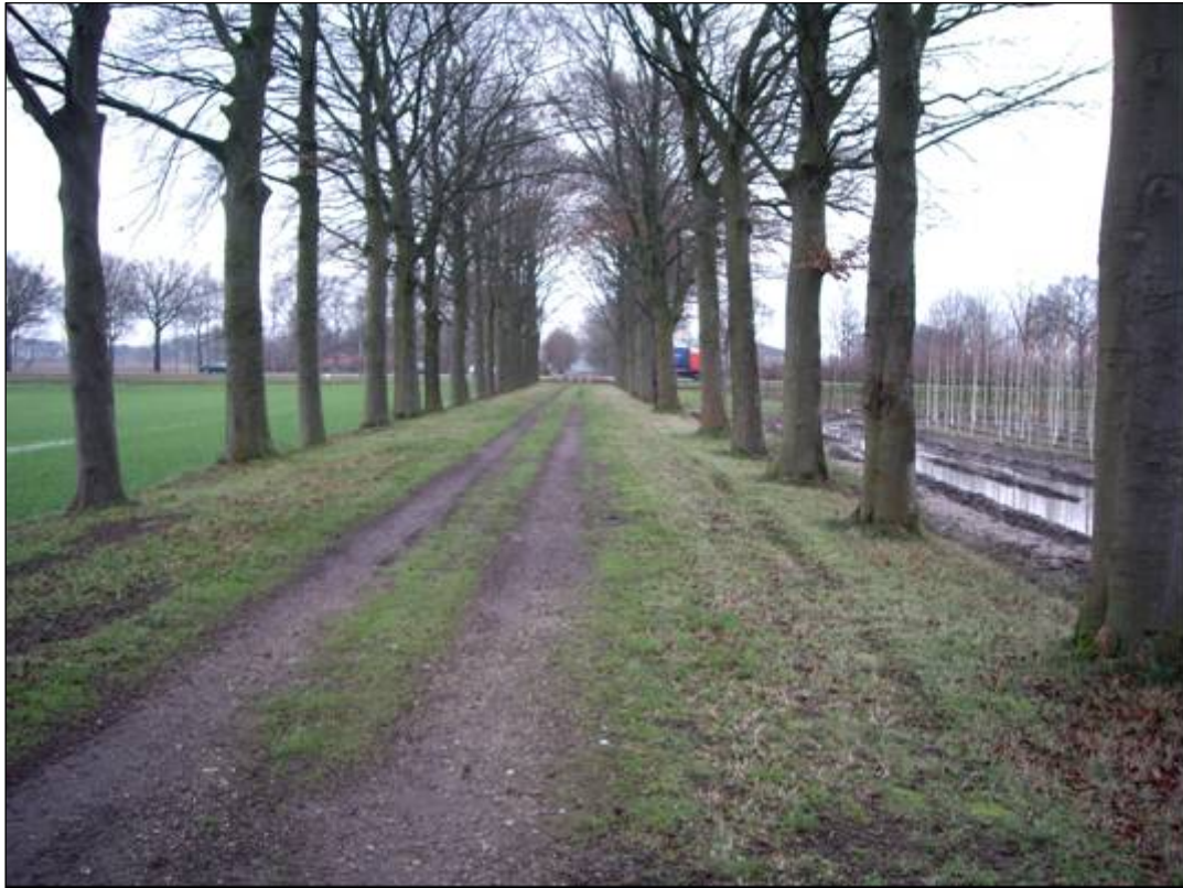
Foto B5.2: Rechts is het gedraineerde perceel te zien en links het niet gedraineerde perceel (Perceel rechts ligt ongeveer 50 cm hoger dan links.)
