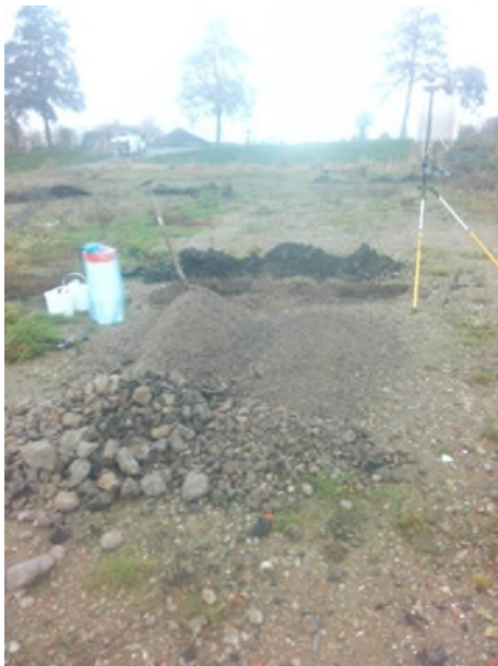
Fotonummer: 47 Omschrijving: Proefgat/boring 4002
