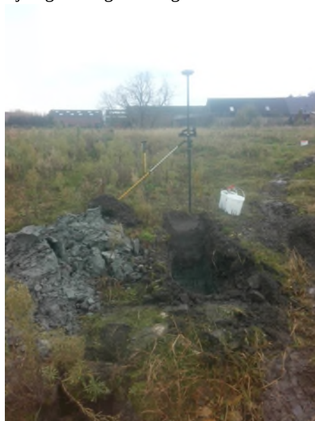
Fotonummer: 66 Omschrijving: Proefgat/boring 4012
