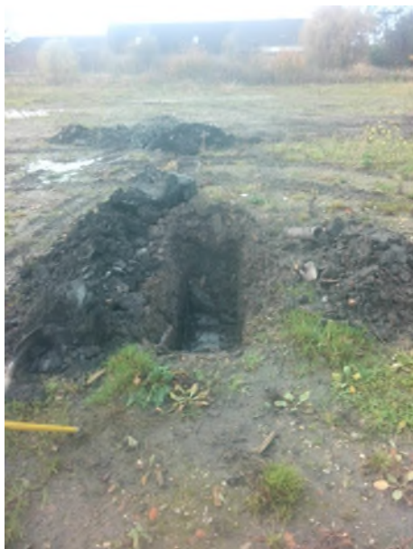
Fotonummer: 45 Omschrijving: Proefgat/boring 4001
