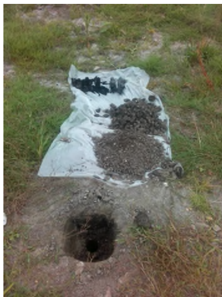
Fotonummer: 26 Omschrijving: Proefgat/boring 3013
