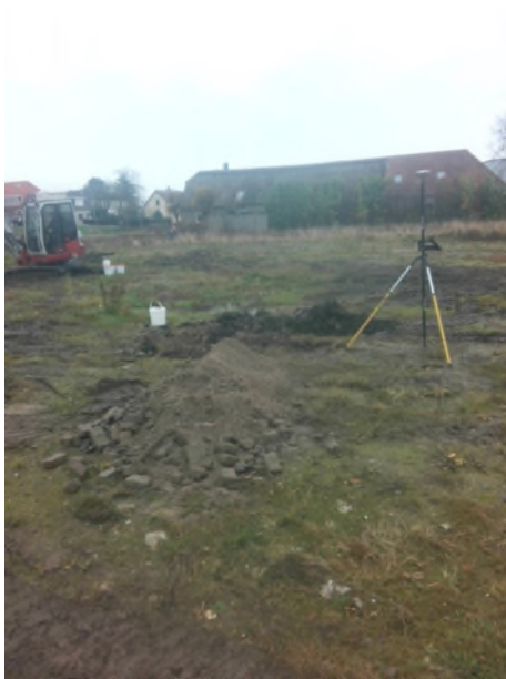
Fotonummer: 71 Omschrijving: Proefgat/boring 4015
