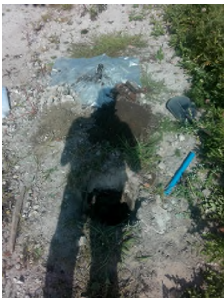
Fotonummer: 21 Omschrijving: Proefgat/boring 3008
