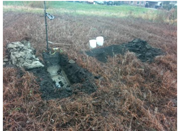
Fotonummer: 72 Omschrijving: Proefgat/boring 4016
