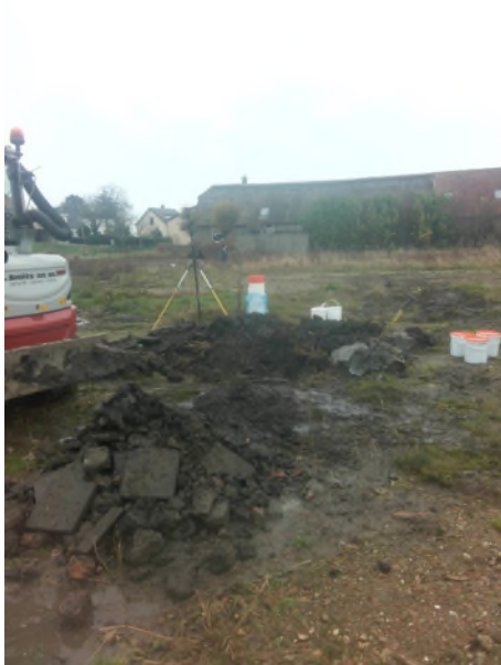
Fotonummer: 69 Omschrijving: Proefgat/boring 4014
