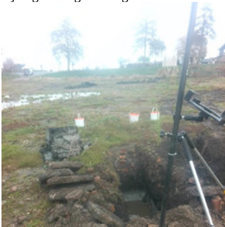
Fotonummer: 57 Omschrijving: Proefgat/boring 4008
