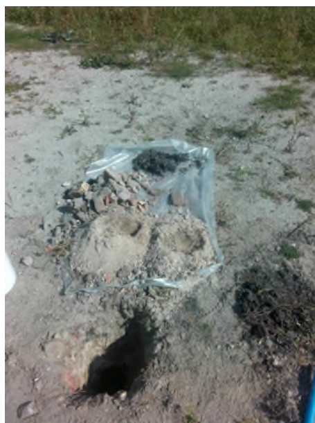
Fotonummer: 22 Omschrijving: Proefgat/boring 3009
