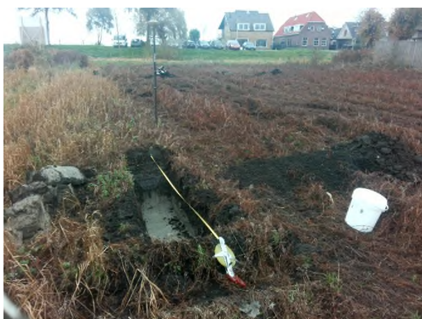
Fotonummer: 61 Omschrijving: Proefgat/boring 4009
