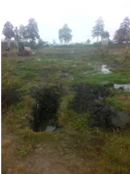
Fotonummer: 63 Omschrijving: Proefgat/boring 4011.
