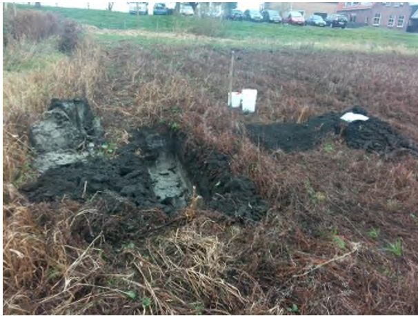
Fotonummer: 67 Omschrijving: Proefgat/boring 4013
