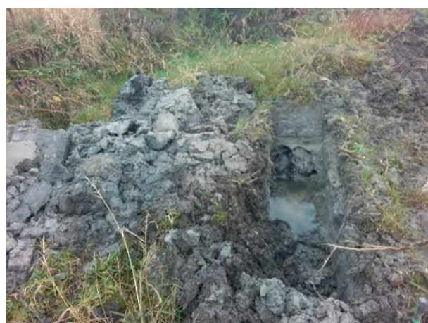
Fotonummer: 62 Omschrijving: Proefgat/boring 4010
