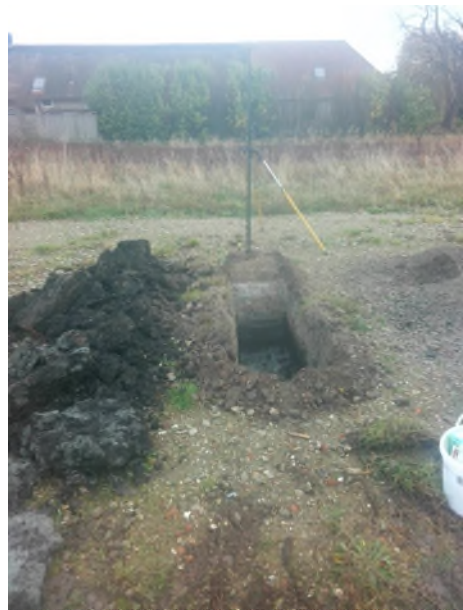
Fotonummer: 48 Omschrijving: Proefgat/boring 4002
