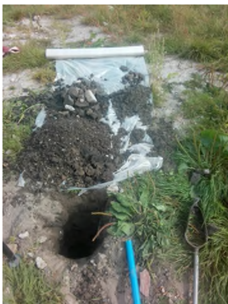
Fotonummer: 37 Omschrijving: Proefgat/boring 3021
