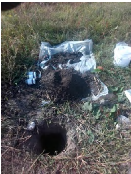
Fotonummer: 31 Omschrijving: Proefgat/boring 3016
