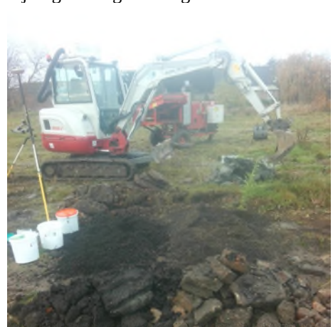
Fotonummer: 58 Omschrijving: Proefgat/boring 4008
