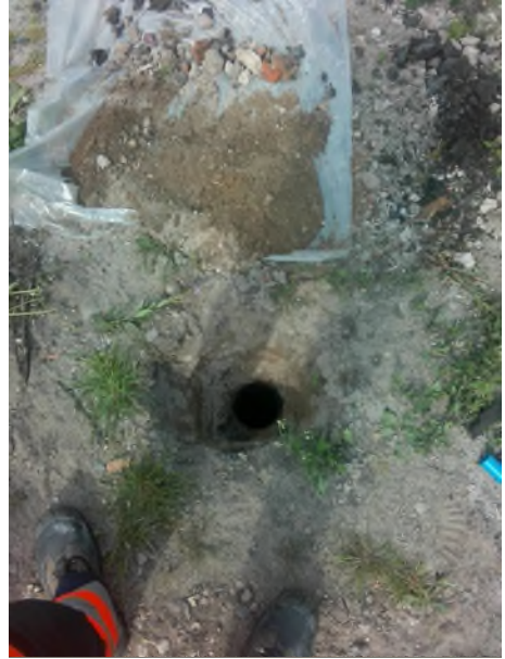
Fotonummer: 16 Omschrijving: Proefgat/boring 3004
