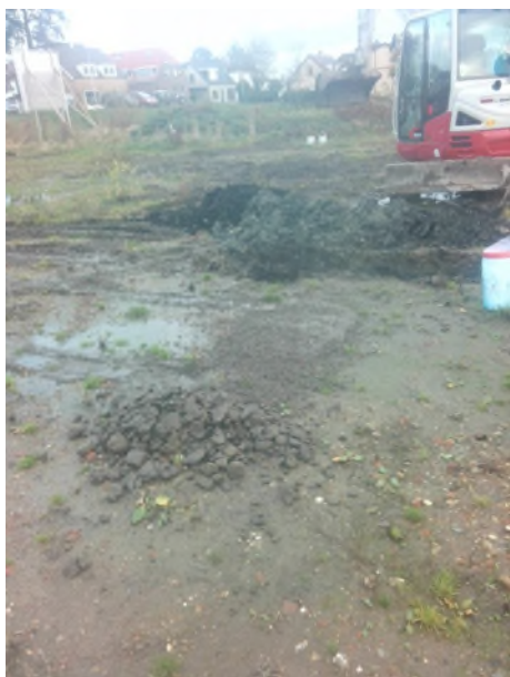
Fotonummer: 59 Omschrijving: Proefgat/boring 4009
