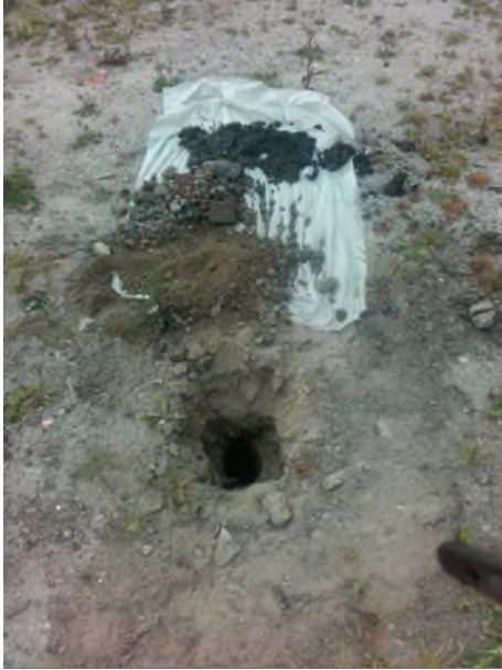
Fotonummer: 15 Omschrijving: Proefgat/boring 3003
