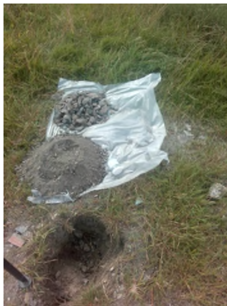
Fotonummer: 36 Omschrijving: Proefgat/boring 3020
