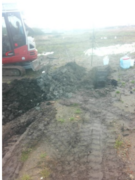
Fotonummer: 60 Omschrijving: Proefgat/boring 4009
