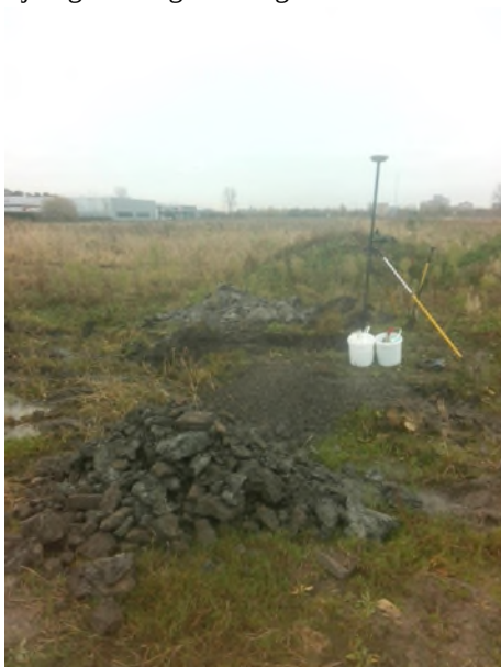
Fotonummer: 65 Omschrijving: Proefgat/boring 4012
