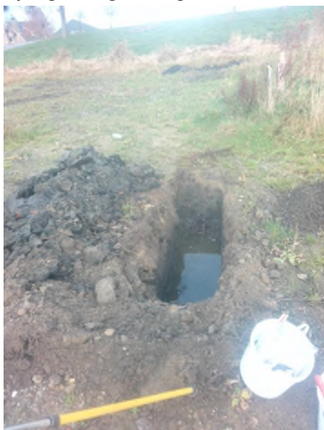
Fotonummer: 53 Omschrijving: Proefgat/boring 4005
