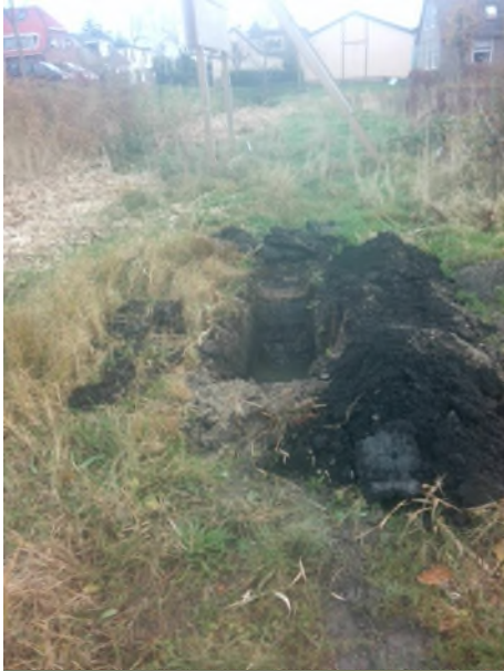
Fotonummer: 55 Omschrijving: Proefgat/boring 4006
