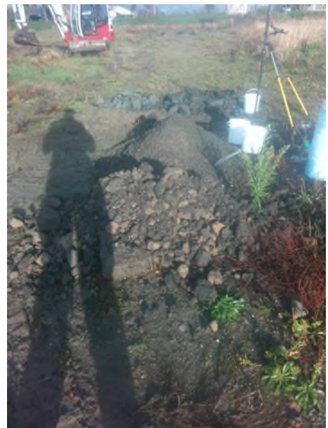
Fotonummer: 50 Omschrijving: Proefgat/boring 4003
