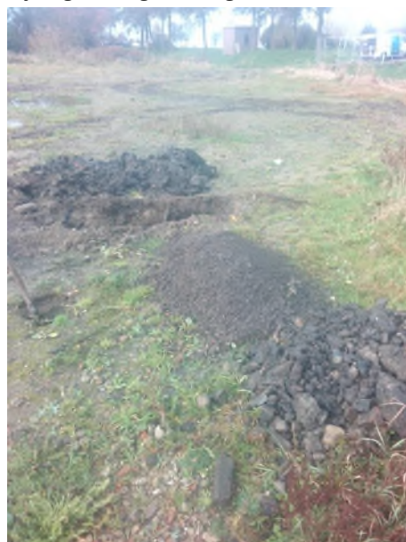
Fotonummer: 54 Omschrijving: Proefgat/boring 4005
