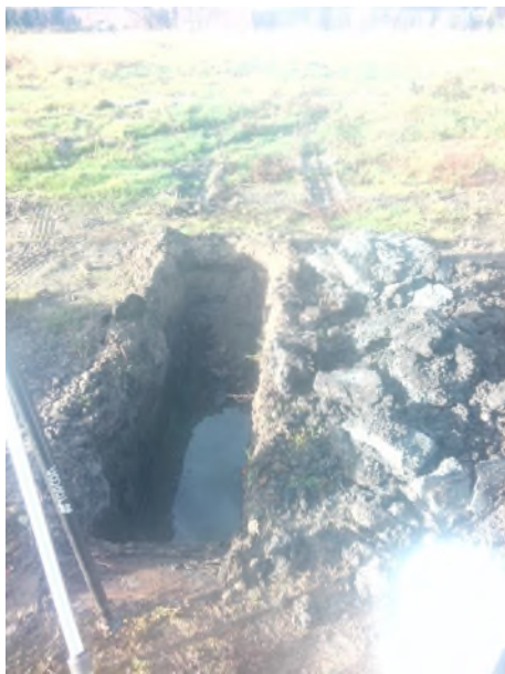
Fotonummer: 49 Omschrijving: Proefgat/boring 4003
