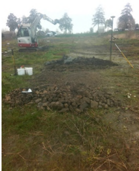
Fotonummer: 51 Omschrijving: Proefgat/boring 4004
