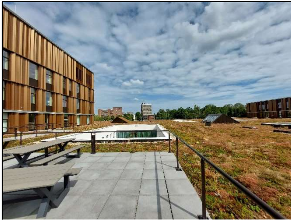
Figuur 2.9 Sedumdak van Isala Meppel
