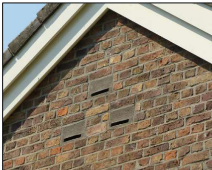
Figuur 2.18 inbouwstenen voor vleermuizen, toegang tot spouwmuur (Zoogdiervereniging, 2020)
