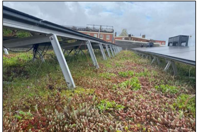
Figuur 2.10 Groen sedumdak met zonnepanelen (solarsedum.nl)
