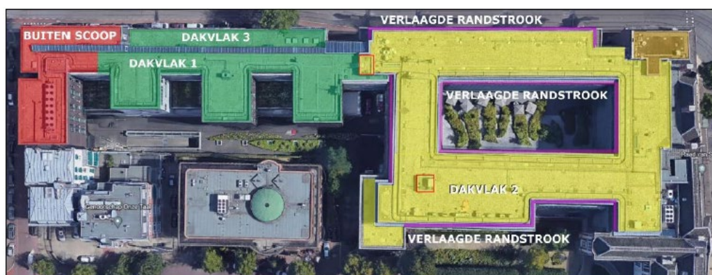
Figuur 1: De betreffende daken: dakvlak 1 t/m 3 (groen, geel en groen).
