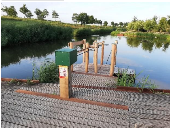
Trekvlot met verbreding en omkasting
