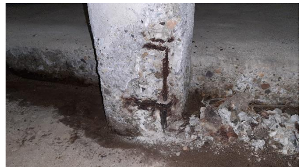
10-11] Aanzicht onderzijde kolom 2. Het schadebeeld aan de onderzijde van kolom 2 is vergelijkbaar met kolom 1. De schade [holklinkende betondekking] manifesteert zich met name in de betondekkingszone. Dieper gelegen beton vertoont een goede samenhang. De hoofdwapening \varnothing 12 en beugelwapening \varnothing 8 is oppervlakkig gecorrodeerd met plaatselijk enige staafreductie. De carbonatatiediepte is circa 20 tot 25 mm.
