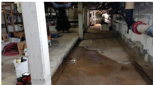
01] Aanzicht van de kolommen in de kelderruimte
