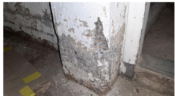
14-15] Aanzicht kolom 4 met vergelijkbare schade aan onderzijde van de kolom.
