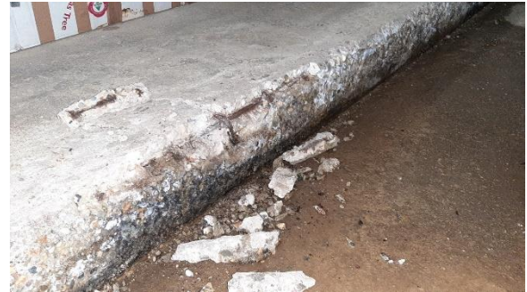
08-09] Bij de vloerrand tussen kolom 1 en 2 is betonschade aanwezig als gevolg van afgedrukte betondekking door wapeningscorrosie.
