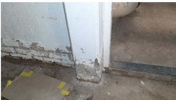
14-15] Aanzicht kolom 4 met vergelijkbare schade aan onderzijde van de kolom.
