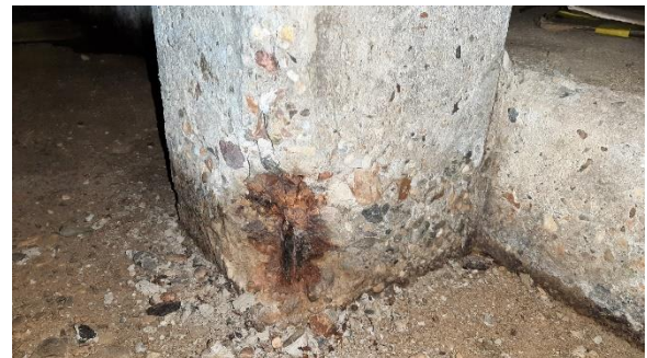
12-13] Aanzicht kolom 3. De schade [holklinkende betondekking] manifesteert zich ook hier met name in de betondekkingszone tot een hoogte van \pm 30 cm boven de vloer. Dieper gelegen beton vertoont een goede samenhang. De hoofdwapening is oppervlakkig gecorrodeerd.
