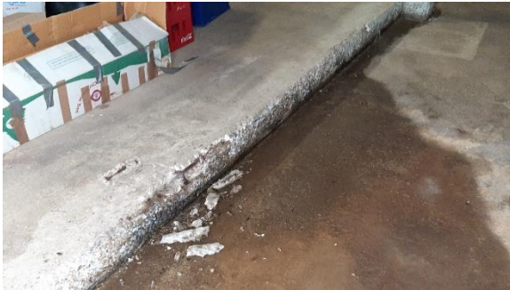
08-09] Bij de vloerrand tussen kolom 1 en 2 is betonschade aanwezig als gevolg van afgedrukte betondekking door wapeningscorrosie.
